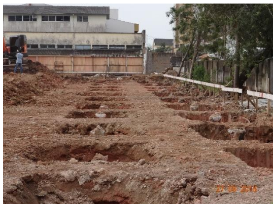
FIGURA 1 – EXECUÇÃO DA FUNDAÇÃO DO MÓDULO M1 DA EEB ADERBAL RAMOS
