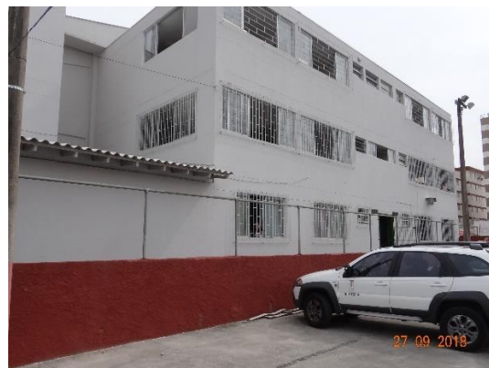
FIGURA 2 – EDIFICAÇÃO EXISTENTE QUE FOI REFORMADA
