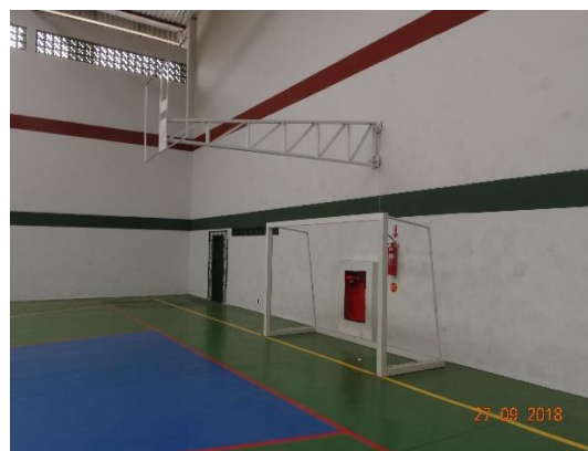
FIGURA 11 – REFORMA NO GINÁSIO DA EEB ADERBAL RAMOS
