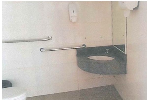
FOTO 2 – LAVATÓRIO DO SANITÁRIO ACESSÍVEL INFANTIL
