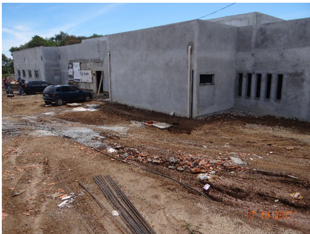
Foto 1 – Vista da fachada da obra.
