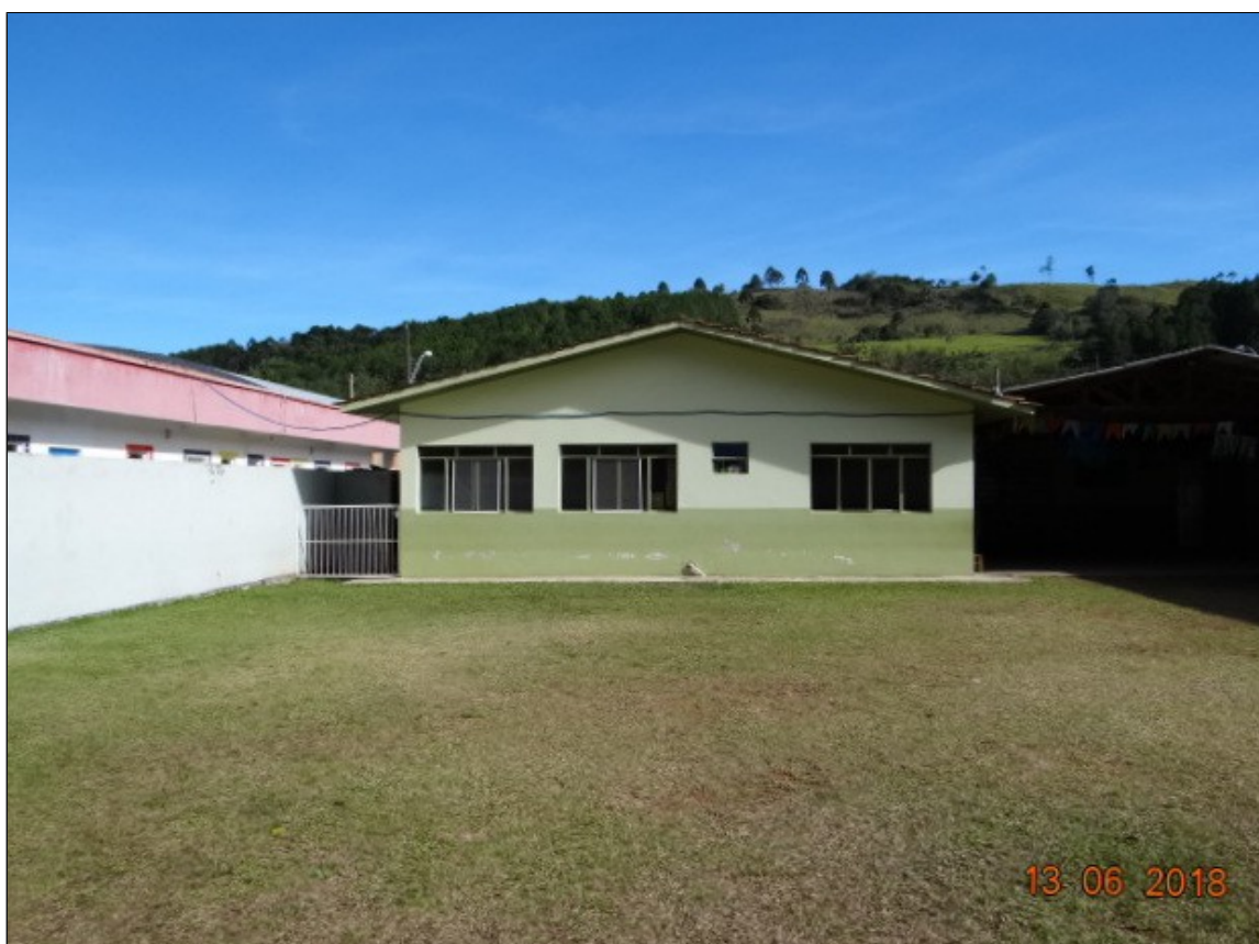
Foto 007 – Pátio externo descoberto não delimitado, umidade ascendente na alvenaria.
