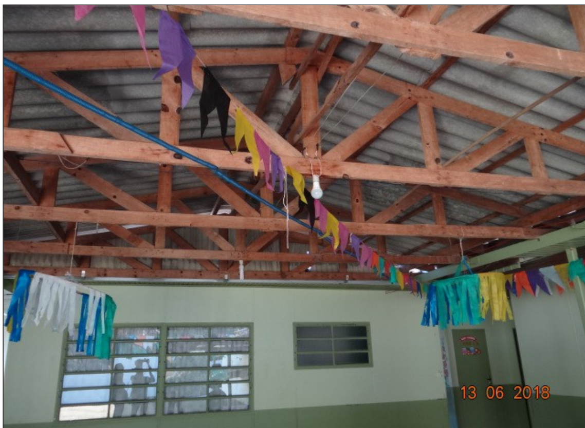
Foto 006 – Pátio coberto, rede elétrica e estrutura de madeira da cobertura aparente.
