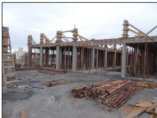
Foto 11 – Terceiro pavimento do Bloco 2. Pilares, vigas e lajes concretadas, faltando as platibandas.
