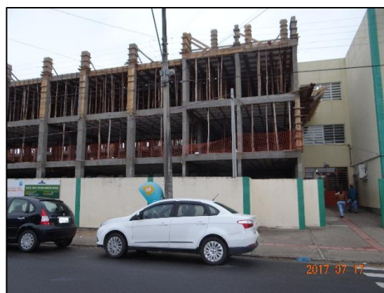
Foto 6 – Vista da frente na junção com a parte antiga.
