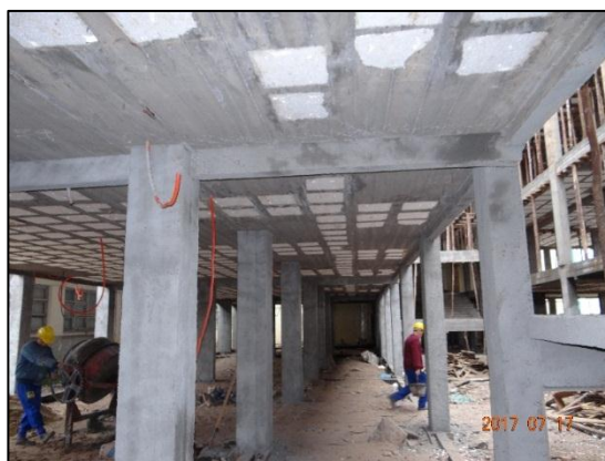
Foto 8 – Pilares e lajes bloco 2
