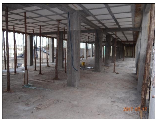
Foto 10 – Pilares e lajes pavimento bloco 2
