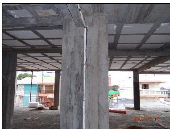
Foto 9 – Execução de junta de dilatação entre os blocos 2 e 3
