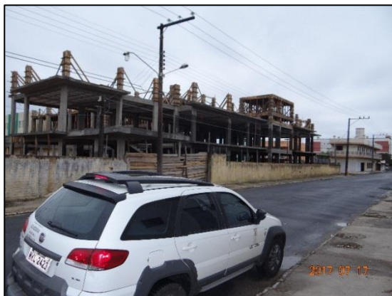
Foto 1 – E.E.B. Professora Maria Garcia Pessi. Fachada Rua Tomaz da Rosa Luz
