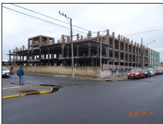
Foto 5 – Vista da frente da obra.
